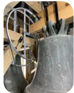
Bis dahin lagerten die sechs Glocken im Turm. Hierzu wurden zwei zusätzliche Stahlträger montiert, an dem alle sechs Glocken mittels Ketten und Spanngurten aufgehängt wurden.
